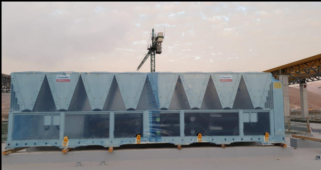
Fotografía N° 6 – Equipos Chillers en cubierta
