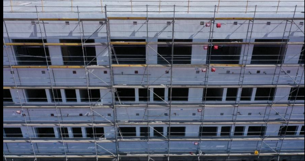
Fotografía N° 2 – instalación sistema EIFS fachada oriente
