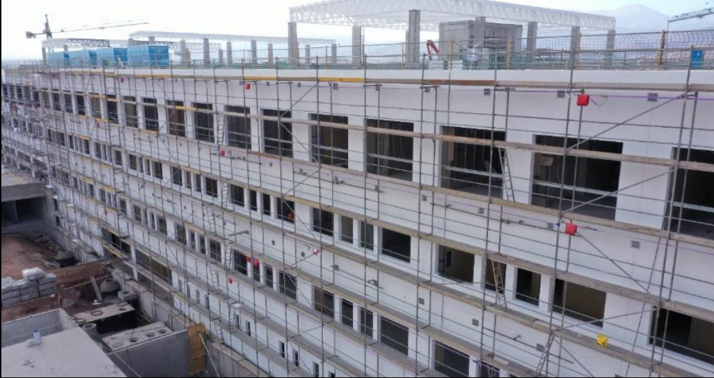
Fotografía N° 1 – instalación sistema EIFS fachada poniente
